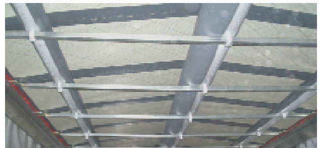
Airpipe hebt die Plane an und lässt das Wasser ablaufen.
